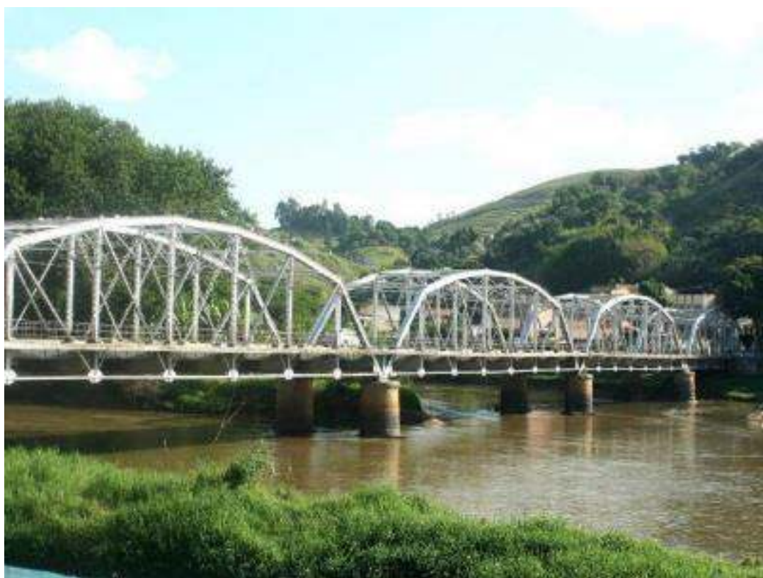
Figura 3 – Ponte Metálica em Barra do Pirai
