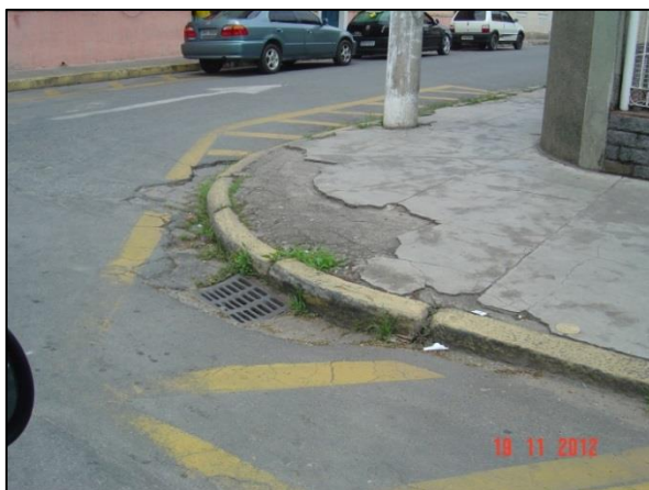
Figura 29 – Boca de lobo localizado no distrito Sede
