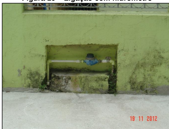
Figura 19 – Ligação com hidrômetro
